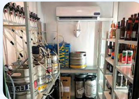
КАМЕРА ДЛЯ ПИВА ПОД КЛЮЧ г. Санкт-Петербург
